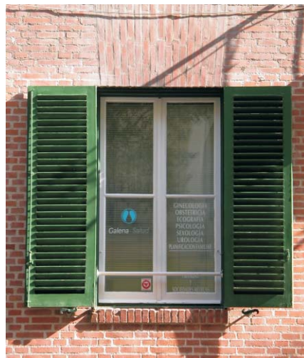
Hilarion Eslava, 2. Ventana de calle en planta baja. Fotografías: MMN Arquitectos, Oct. 2003
