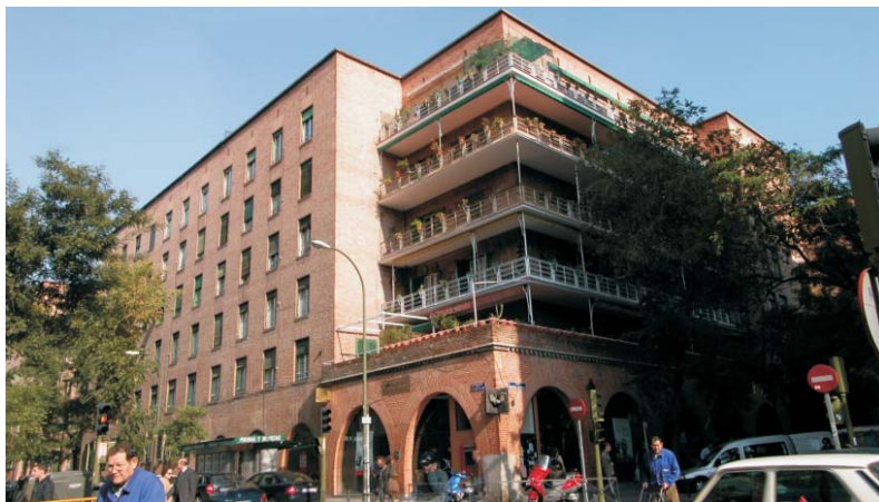
Esquina de Rodríguez San Pedro con Hilarión Eslava. MMN Arquitectos, Nov. 2003
