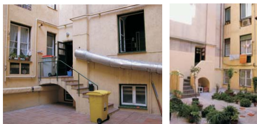
Escalera de acceso a patio en Gaztambide 21
