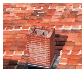
Alteraciones en las viviendas que no contemplan la estructura funcional del edificio en el que se sitúan han provocado la aparición de chimeneas de nueva construcción. Estos elementos además de introducir variaciones de aspecto también introducen nuevos puntos conflictivos constructivamente. Fotografía: MMN Arquitectos. Octubre 2003.
