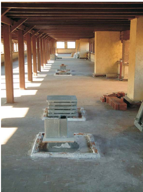
Foto 1 - Chimeneas de nueva construcción en zonas comunes de tendedero en cubierta. Fotografía: MMN Arquitectos. Octubre 2003.
